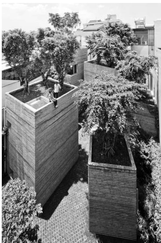
Obr. 15 Fotografie Domu pro stromy v Ho Či Minově městě ve Vietnamu, jak jej navrhl architekt Võ Trọng Nghĩa. Autorem fotografií je Hiroyuki Oki a byly reprodukovány s jeho svolením.
